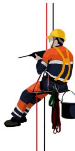
Рис. 2. Работы с веревочного доступа
